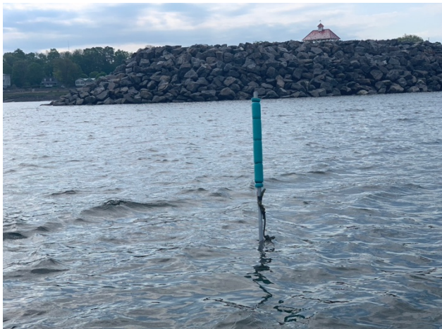
Balises vertes du côté Est
